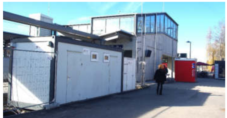
Eingangsbereich Bahnhof Lindau-Reutin.
